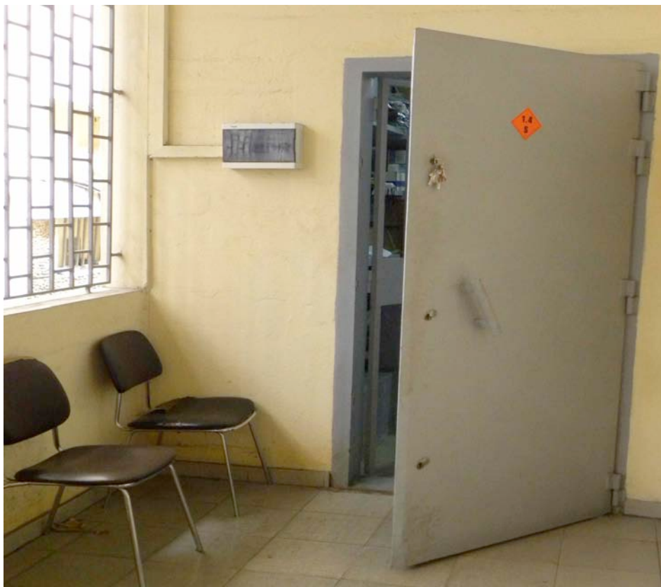
Photo 10 : Dans cette image, il est possible d'observer un dispositif d'accès en plusieurs composantes (grillage externe empêchant l'accès aux portes, une porte épaisse en acier et un second grillage qui sert de guichet pour la sortie du matériel.
